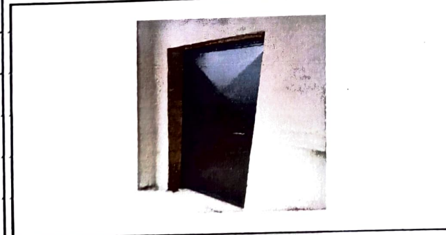
Foto 5: 100 % de reparación de la puerta del aula.
